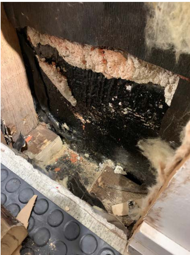
Valesokkelia vasten bitumisively. Myös alaohjauspuun alapuolella on bitumisively
