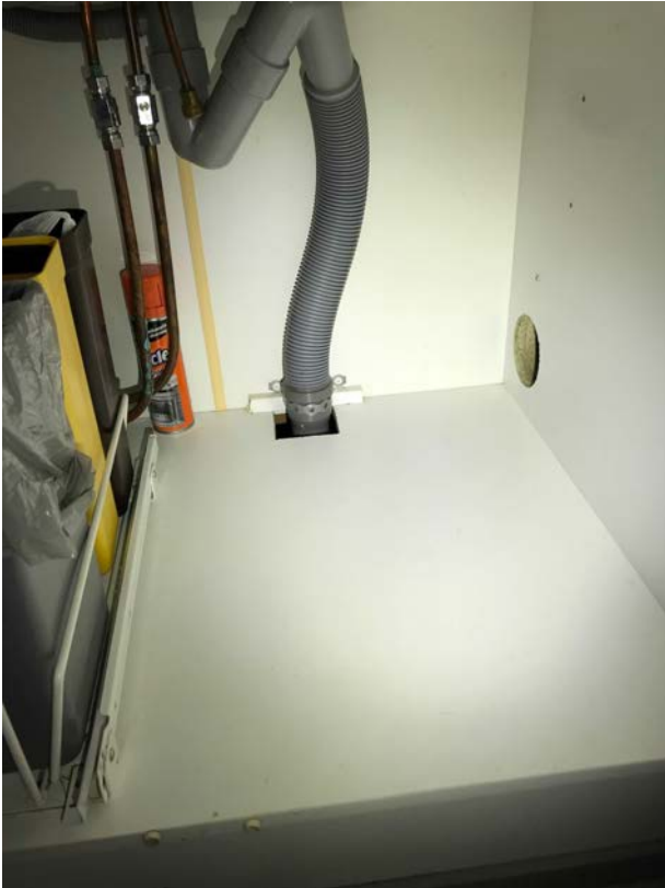
Asunto yksi: keittiön allaskaapin takana reikä, mistä tule hajuja. Keittiön allaskaapissa ei ole vuotoallasta
