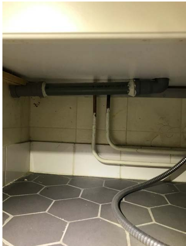
Viemäri kiertää seinän kautta sivummalle ja sieltä liittyy lattiakaivoon
