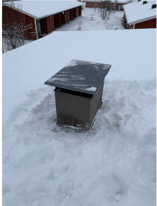
Ilmanvaihdon poistokanavat oikein pellitetty
