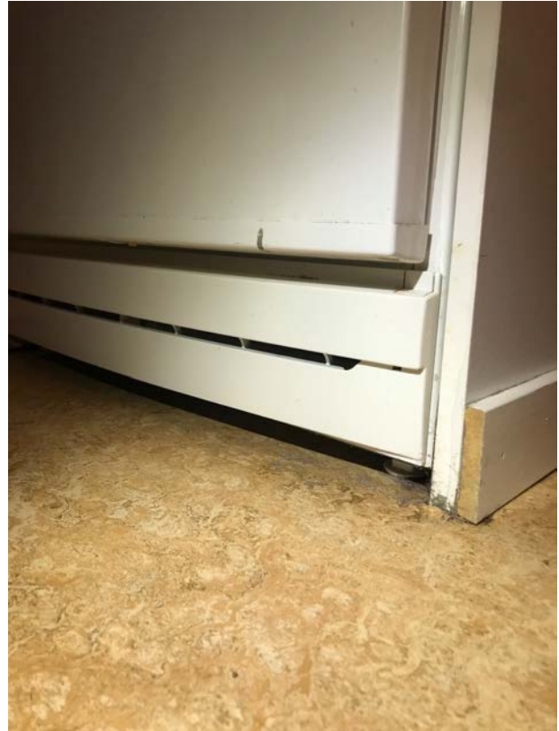
Asunto kaksi: jääkaapin alla ei ole vuoto allasta
