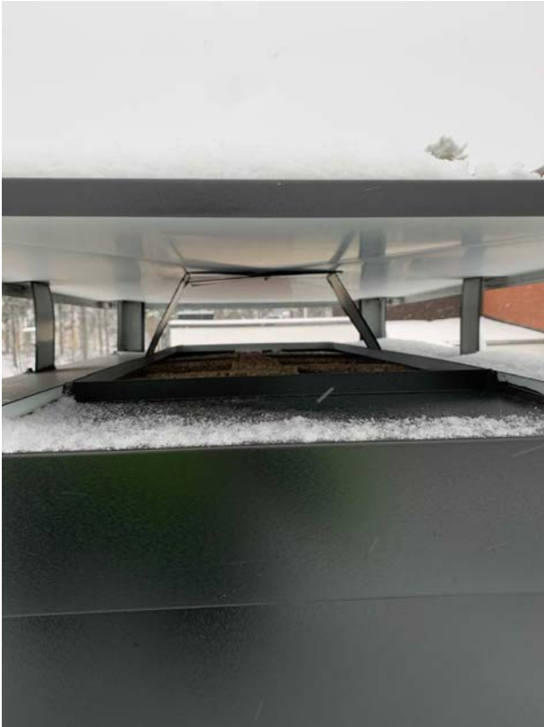
Pellityksien kallistukset hyvät savupiipussa
