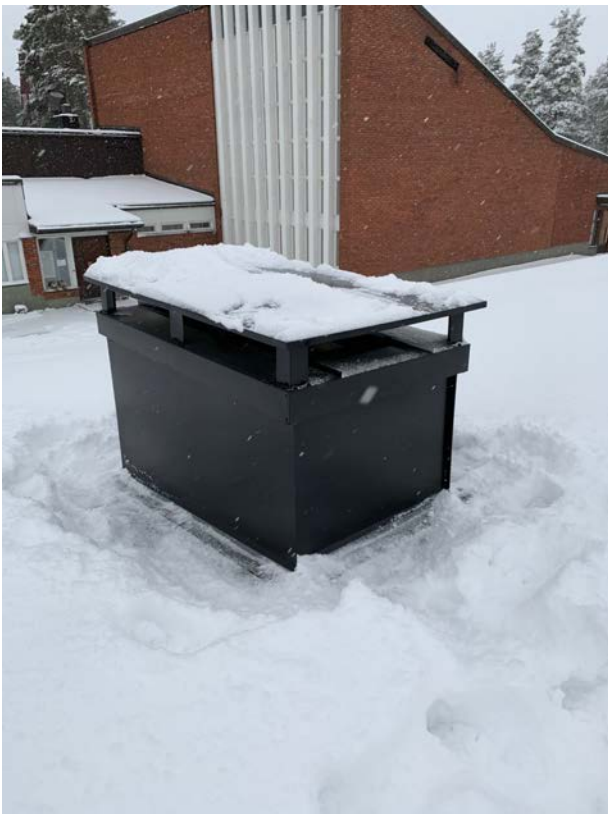
Savupiipu pellitetty oikein ja piipunhattu asennettu
