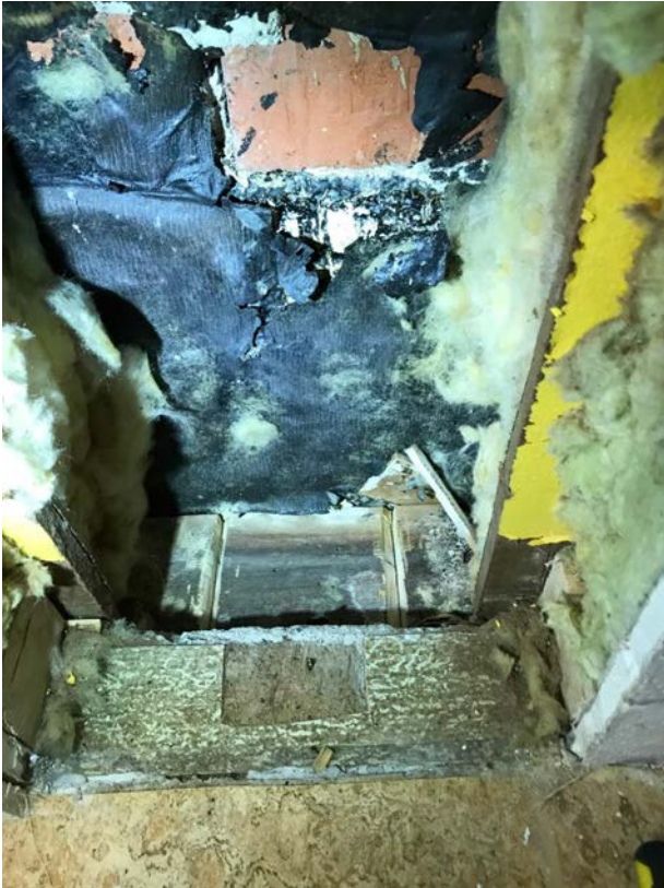
Bitumisively alaohjauspuun alla ja sokkelia vasten
