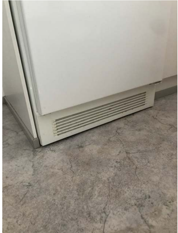
Asunto yksi: jääkaapin alla ei ole vuotoallasta
