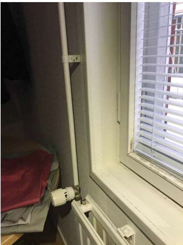
Asunto kaksi: osa päädyn ulko seinistä on lisälämmöneristetty
