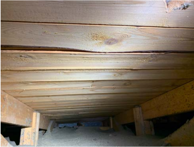
Yläpohja tuulettuu sivuräystäiden kautta
