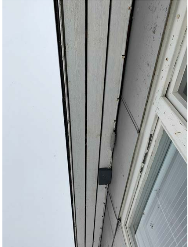
Yläpohja tuulettuu sivuräystäiden kautta
