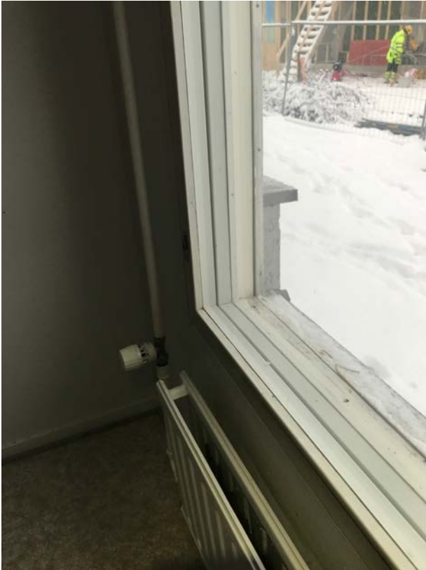
Ikkunat MS 2 lasinen ikkuna. Ulommainen kolmas ikkuna ilmeisesti asennettu jälkikäteen?
