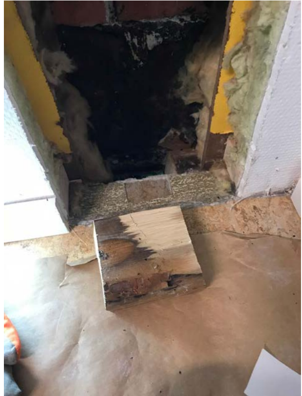
Bitumisively alaohjauspuun alla ja sokkelia vasten
