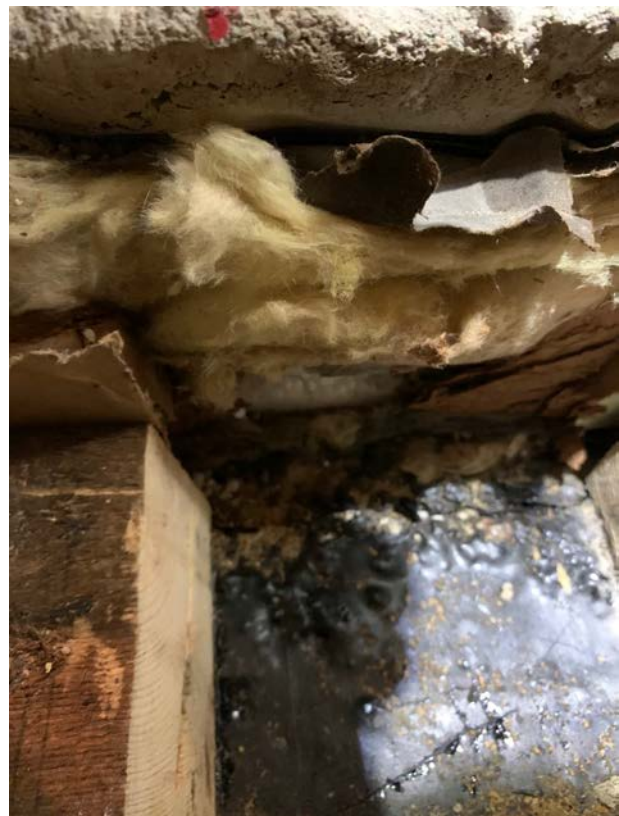
Alapohjassa eps (styrox) eristeenä. Mineraalivilla on lisätty reuna-alueelle tiivistykseksi. Mineraalivillaa ei havaittu alapohja eristeenä.
