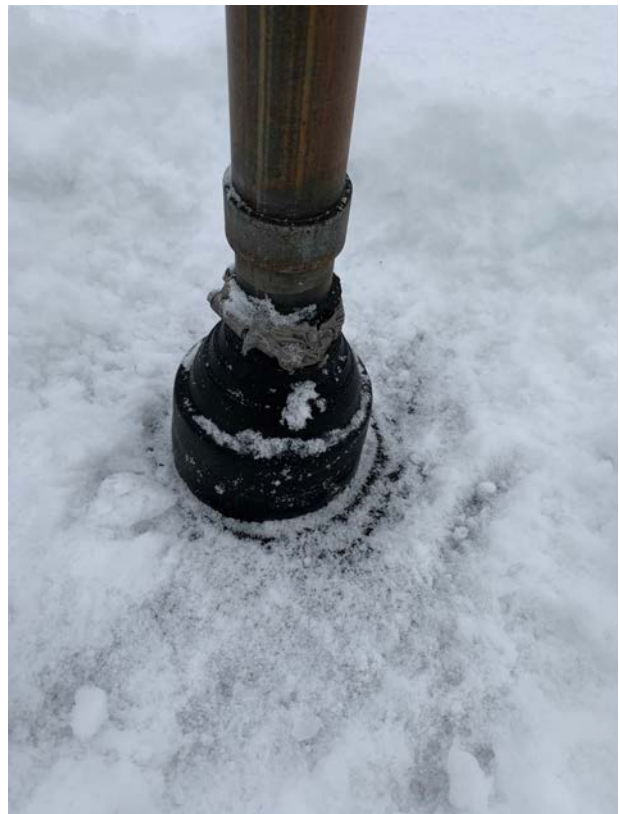
Savupiipu pellitetty oikein ja piipunhattu asennettu
