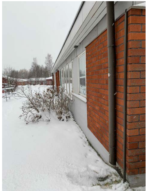
Maanpinta on korkealla, laskettava maanpintaa
