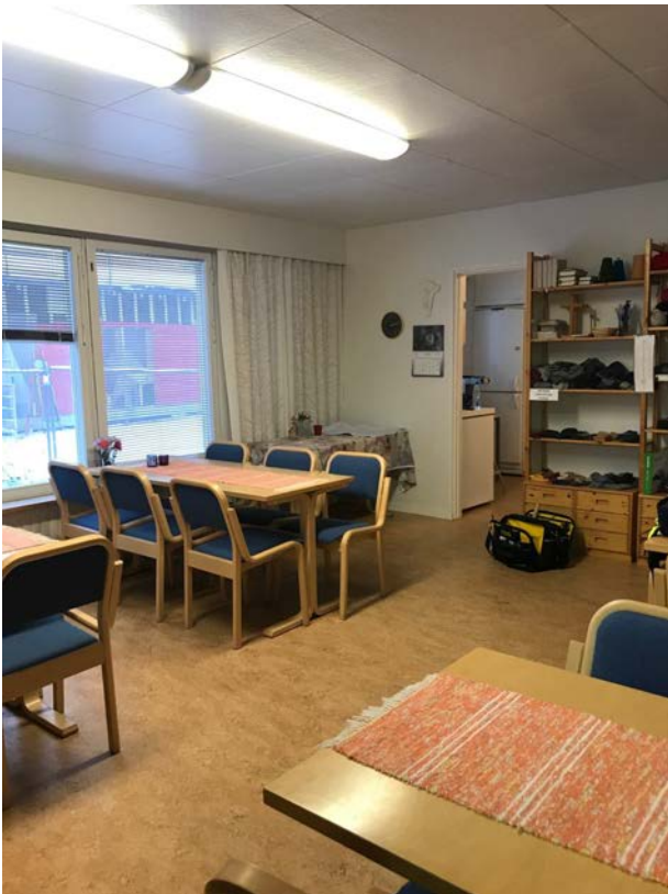
Asunto kaksi: lattiassa linoleumi, seinät lastulevyä ja Ässätex- tapetti, katossa Halltex-levy (puolikova kuitulevy)
