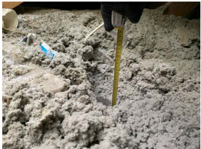
Yläpohjassa eristettä n. 20cm. Havaittu ilmansulkupaperi yläpohjassa
