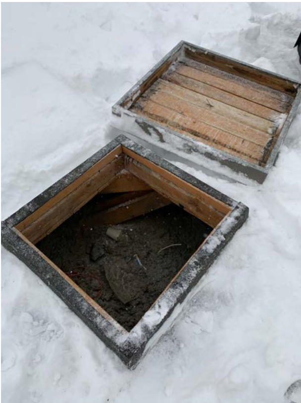
Yläpohjaan pääsy kattoluukun kautta
