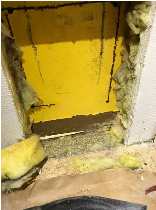
Sisäpuolinen lämmöneristys
